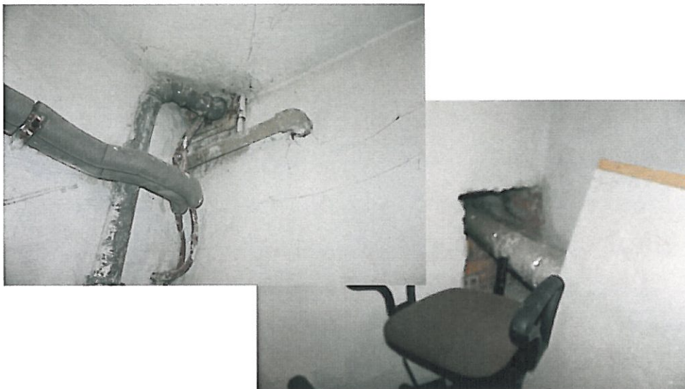
fot 2.) Nie obudowane przepusty instalacyjne w pomieszczeniu wentylatorni (opracowanie własne)
