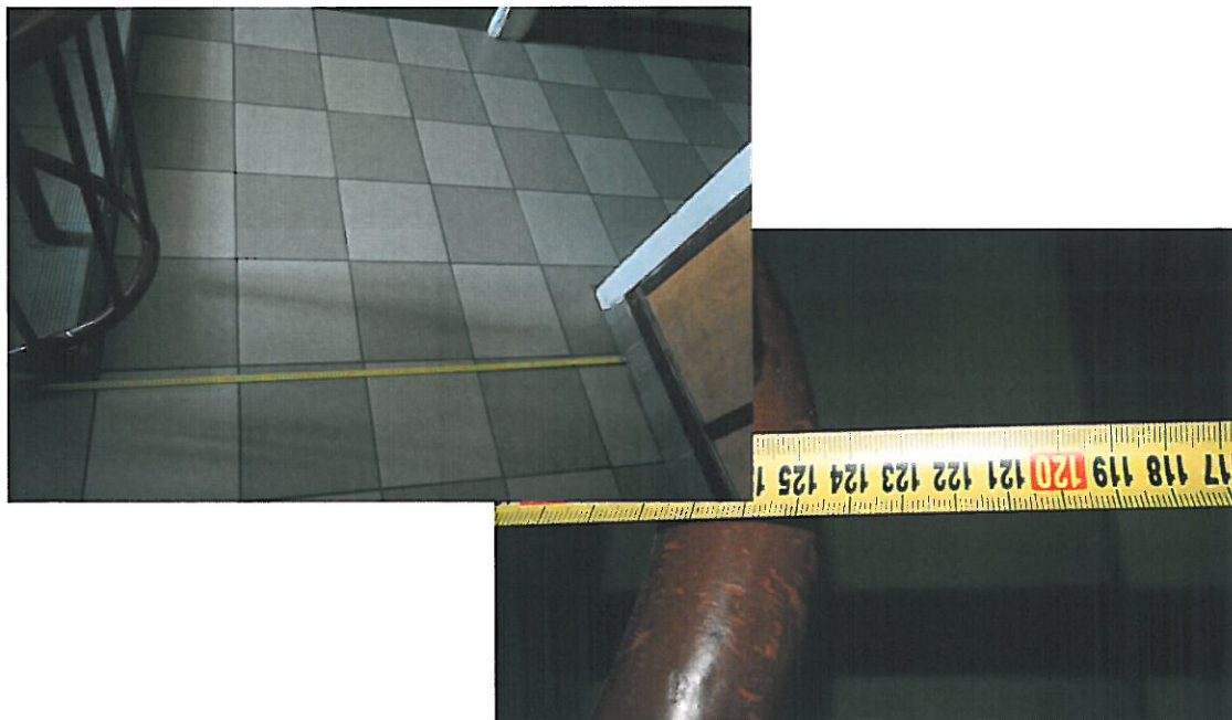
fot. 5. Szerokość użytkowa spocznika klatki schodowej K3 wartość 1,25 m. (opracowanie własne)
