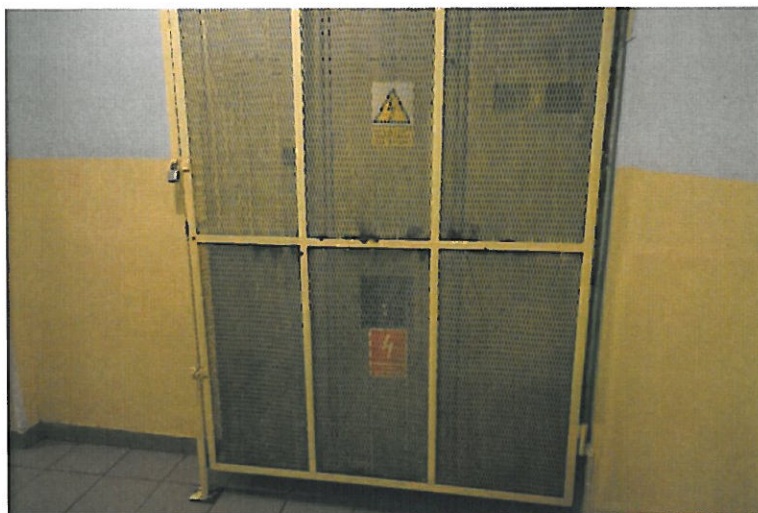
fot. 8. Przeciwpowozarowy wyl4cznik pr4du (opracowanie wlasne)
