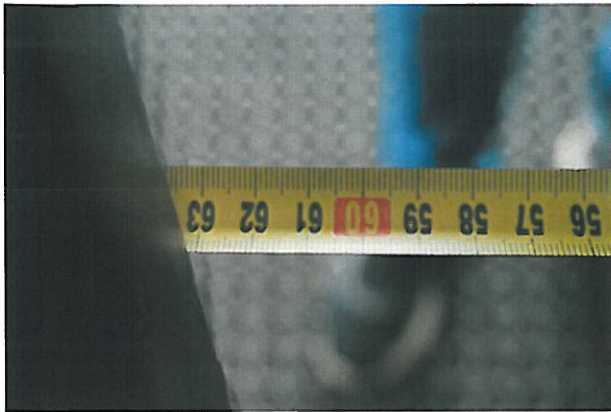
fot. 6. Szerokość drzwi ewakuacyjnych na zewnątrz budynku – skrzydło nieblokowane 0,63 m (opracowanie własne)
